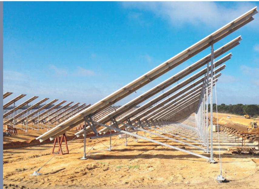
El Tornillo de fundación parte de la idea de un sistema de aplicación fácil y funcional, evitando de este modo el arduo proceso de excavación, hormigonado y rellenado, además de adaptarse a la necesidad de cada cliente ya que se trata de un producto muy estable y resistente con un alto abanico de aplicaciones que permite cubrir todos los parámetros requeridos para cada ejecución. Por otro lado, el tornillo de fundamento se puede quitar fácilmente lo que lo convierte en un producto reutilizable.
